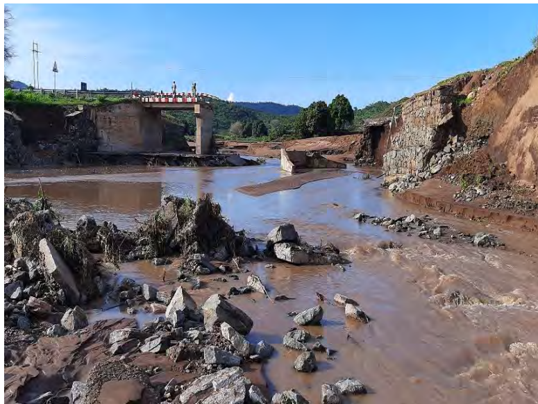
Kitumba/Mirumba bridge along Katete – Kibaoni (Katavi)
